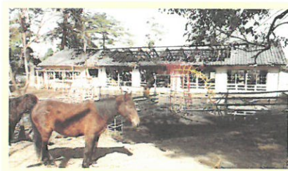
昭和52年3月10日本館消失
